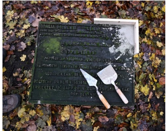
Der alte Gedenkstein wird repariert.
