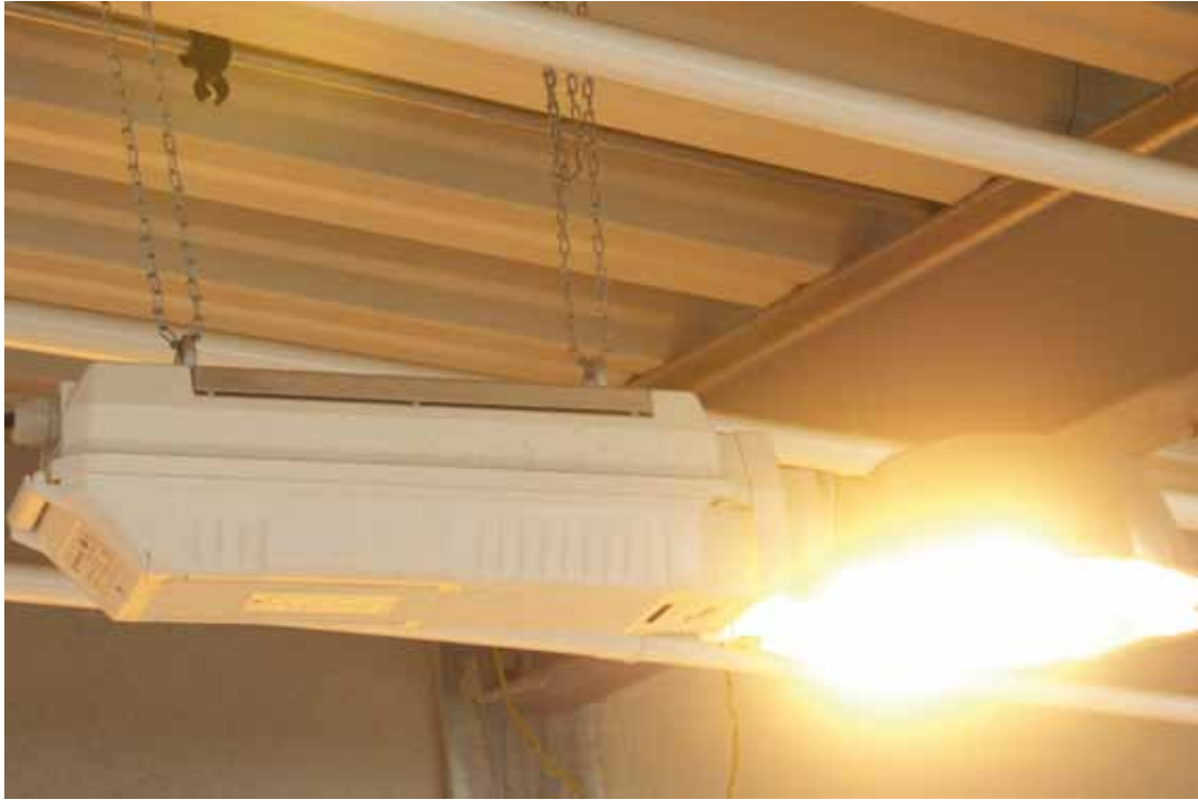
Quecksilberhochdruckdampf Lampe mit 400 W
